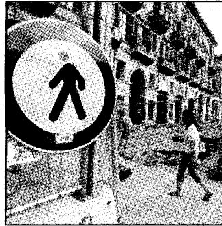
Il cantiere del metrò
